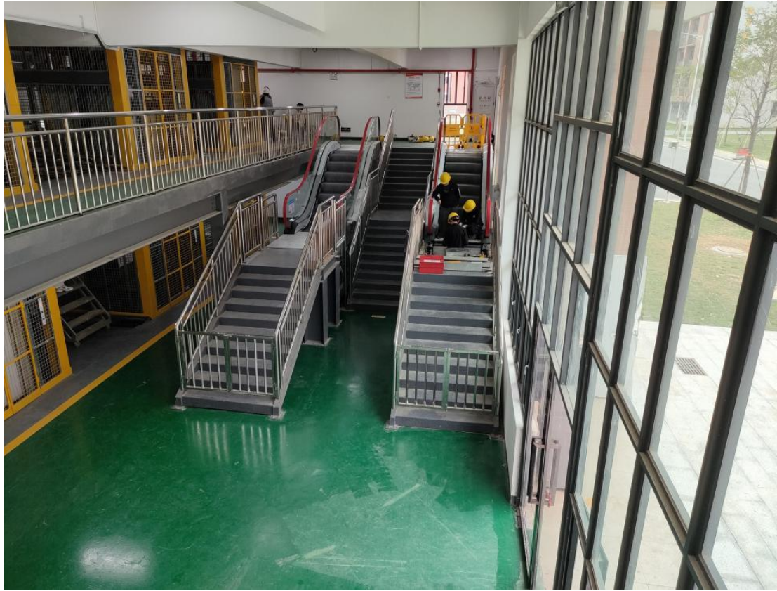
图 5-12 钟陈石老师指导 19 级电梯专业学生进行电扶梯维保实操（迅达黄带培训）
